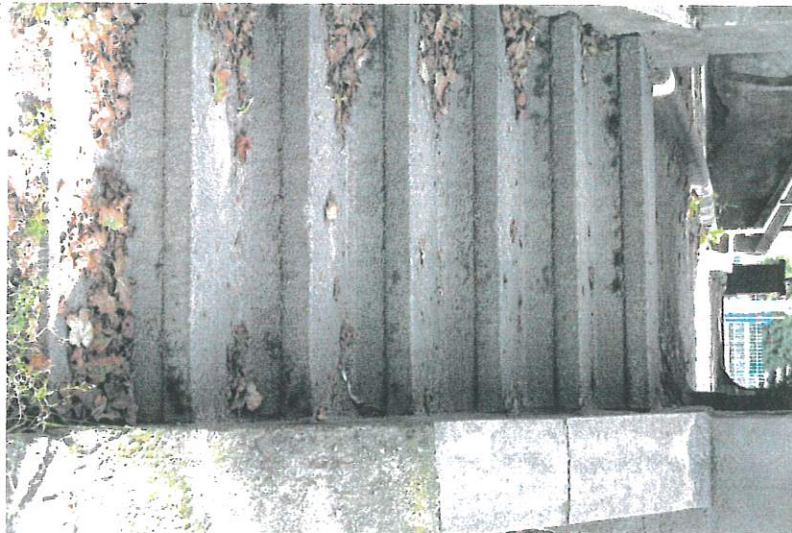
13. Schody prowadzące do ogrodu /uszkodzenia tynku w cokole/.
