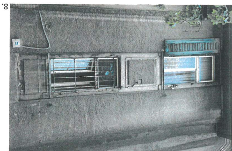
7. Tynk dwuwarstwowy - podkładowy gładki i wierzchni fakturalny
