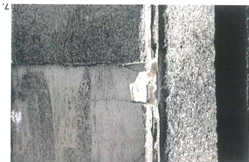
7. Tynk dwuwarstwowy - podkładowy gładki i wierzchni fakturalny
